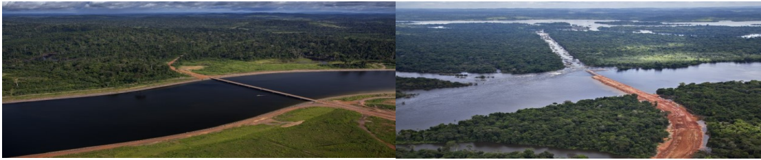
Fotos das obras no canteiro do Sítio Pimental feita em abril de 2012 pelo Greenpeace
